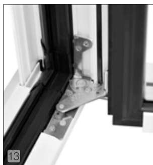
13 ferramenta e asole di drenaggio scarico acqua a scomparsa, vista interna
